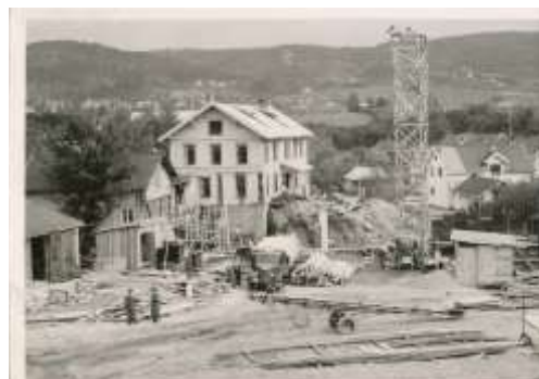
Bildet viser starten på 1. byggetrinn av Lier rådhus, tidlig på 1950-tallet.
